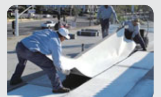
UltraWhiteシートの施工風景
