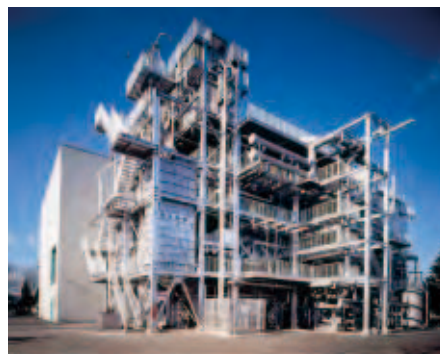
栃木工場焼却発電施設
