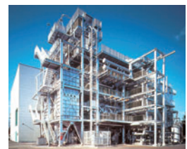
栃木工場焼却発電設備
