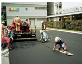
弾性舗装施工状況
