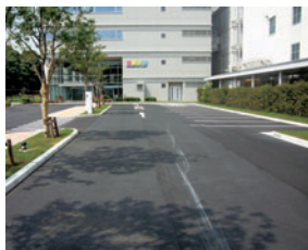
弾性舗装施工路面
