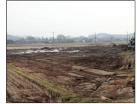
廃タイヤ撤去後
