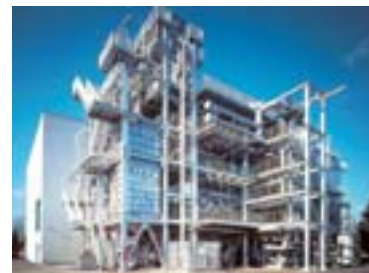
栃木工場焼却発電施設
