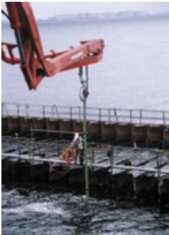
洋上でのゴム入り固化処理土の打設
